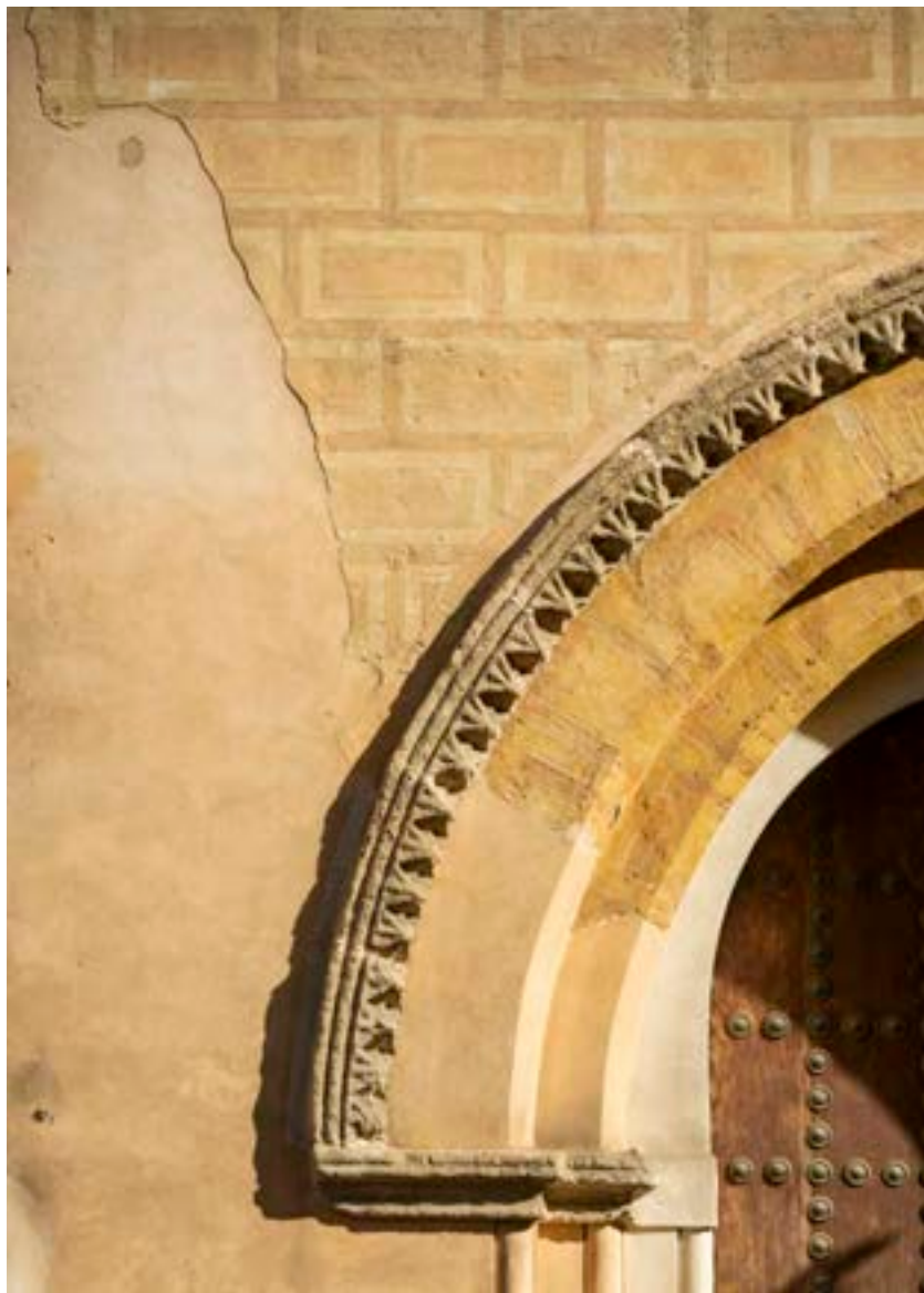
Figura 6.- Pintura mural con dibujo inciso fingiendo aparejo de sillares almohadillados sin chaflanes angulares. Iglesia de Santa María la Blanca. Sevilla. 2023. Fot. Javier Callejas
