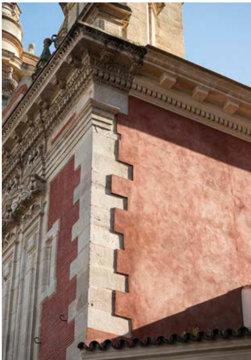
Figura 5.- Mortero de cal coloreado en masa, enalmagrado. Iglesia del Divino Salvador de Sevilla. 2024. Fot. Fernando Alda
